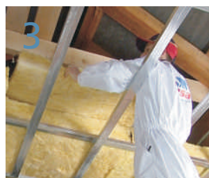
postavimo drugi sloj izolacije
