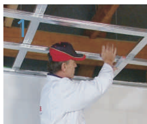
postavimo metalnu konstrukciju
