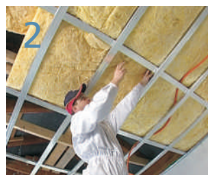
postavimo prvi sloj izolacije
