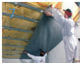
7 Na C profil obostrano ljepljivom trakom nalijepimo parnu zapreku ili parnu branu
