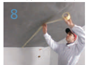
8 Svi spojevi, proboji i priključci na foliji moraju biti zabrtvljeni i zalijepljeni
