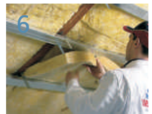
6 Na rogove pričvrstimo metalne držače i C profil iza kojeg umetnemo drugi sloj izol.
