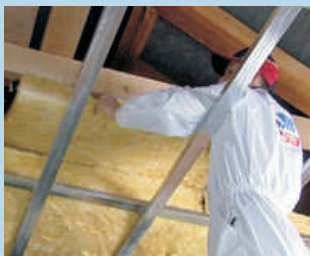
3 Postavimo drugi sloj izolacije
