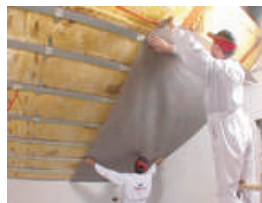
7 Na C - profil obostrano ljepljivom trakom naljepimo parnu prepreku
