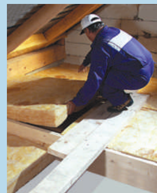
2 Polaganje drugog sloja izolacije. Kod rezanja na odgovarajuće dimenzije dodajte 2 cm
