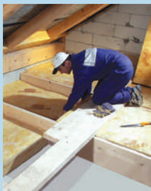
1 Između drvenih nosača položimo prvi sloj izolacije
