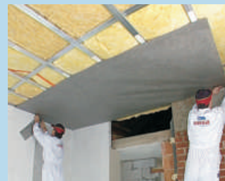
4 Prilijepimo zaštitnu foliju - parnu zapreku (S d ≥ 2 m - 10 m)
