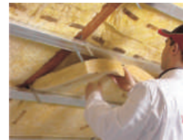
6 Iza metalnog C - profila umetnemo drugi sloj izolacije
