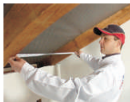
3 Kod izmjere računamo 1 do 2 cm više zbog boljeg brtvljenja
